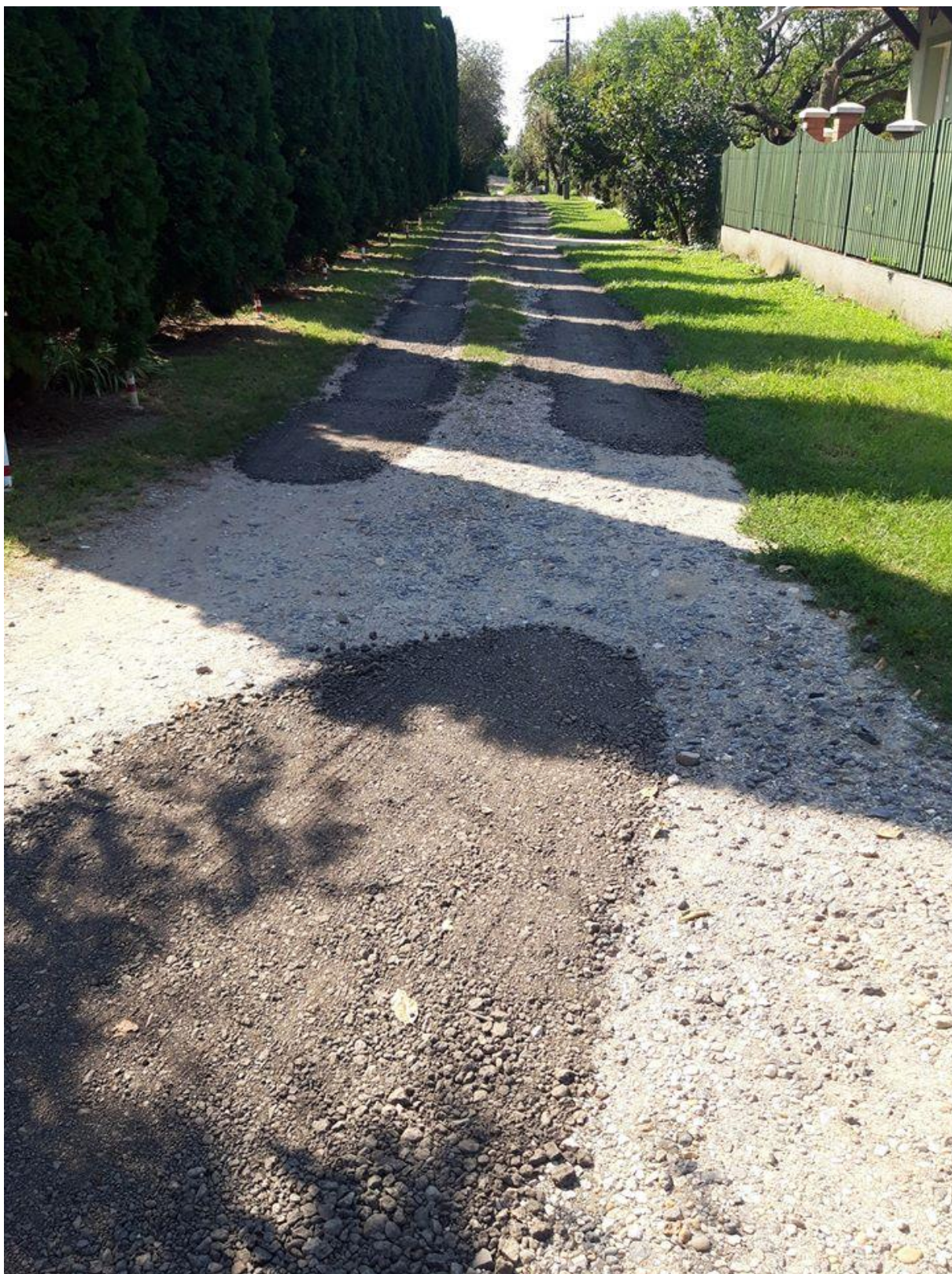
Útjavítás kiskertekben darált aszfalttal
