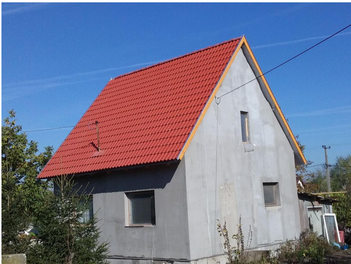
Villámcsapás következtében leégett tető újjáépítése
